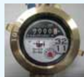
水道メーター写真
