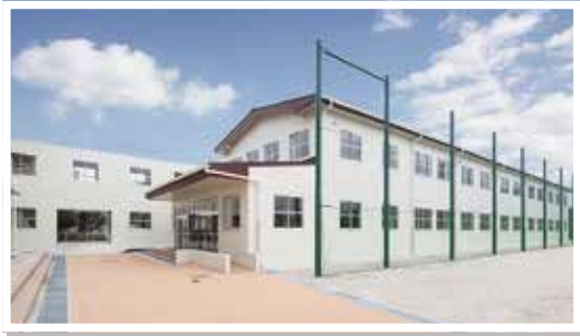
粕屋中央小学校に新たに校舎を増築し、既存校舎の改造も行いました。
