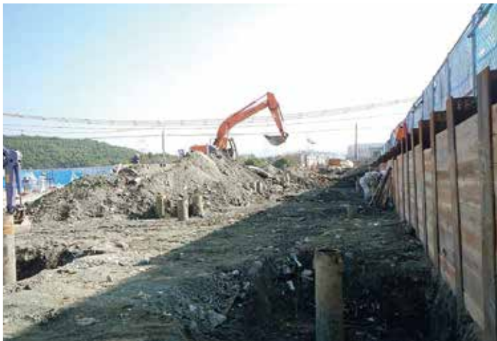
新給食センター工事の様子
