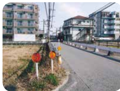
伊賀・仲原線1.2mの歩道ができるどころ
