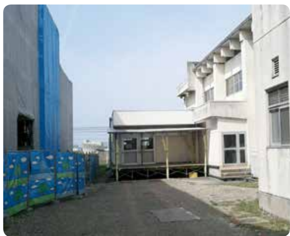
現在の給食センターと建設中の建物の間の砂利の敷地
