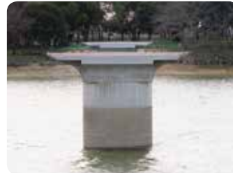
残された橋脚2基
