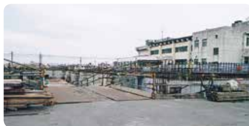
建設中の新給食センター
