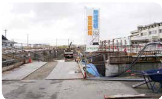
給食センター建設現場
