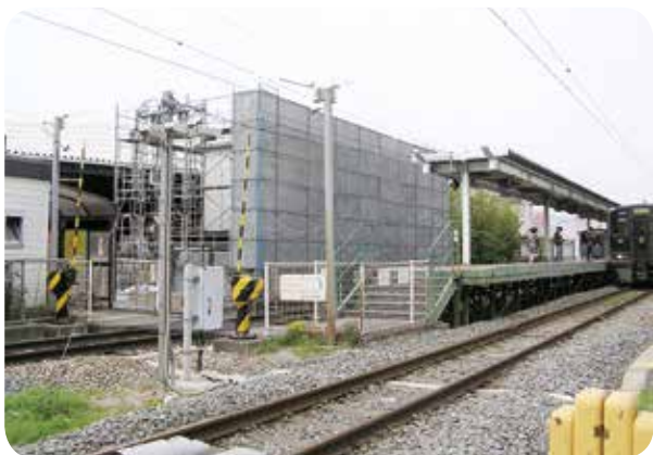
柚須駅プラットフォーム改築工事
