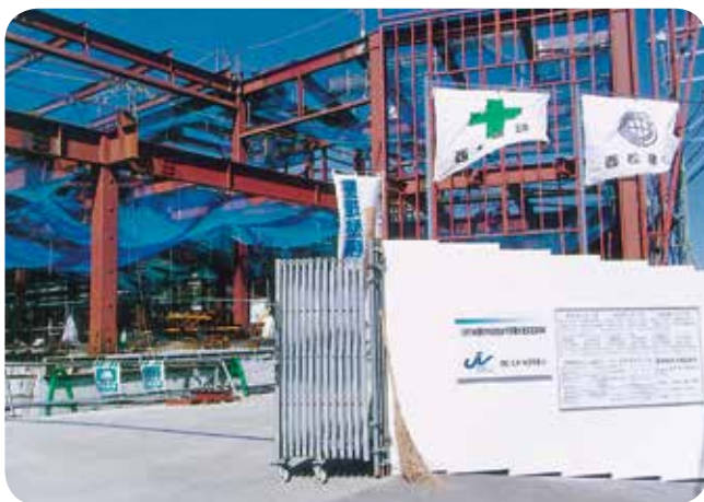
建設中の学校給食共同調理場
