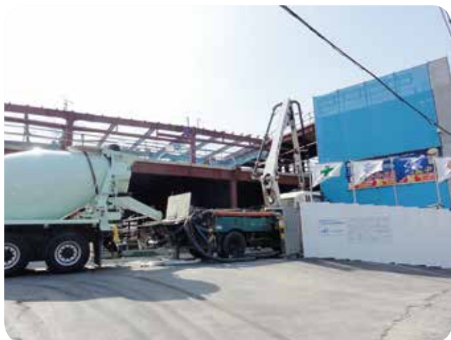
建設中の学校給食センター
