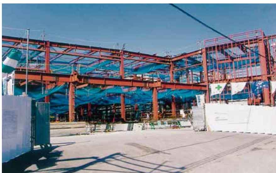
建設が進む学校給食センター
