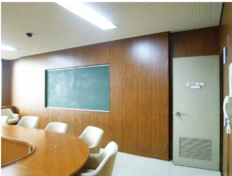
間仕切り撤去工事が行われる委員会室
